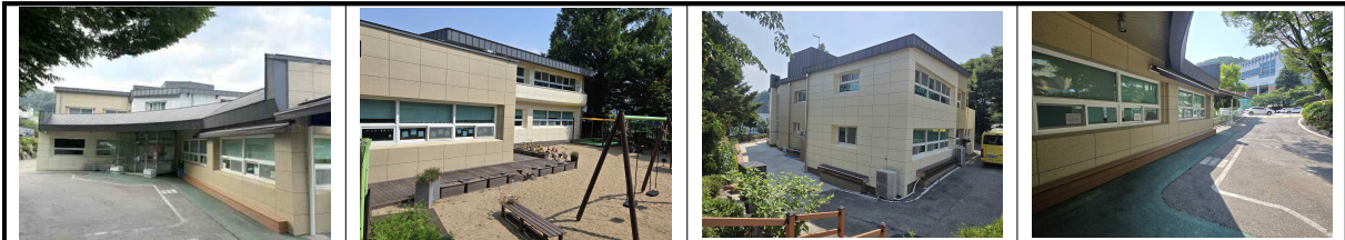
유치원 외벽 공사
